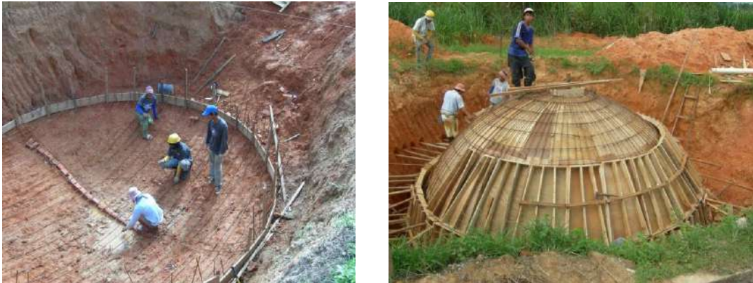
Gambar 6: Kerja-Kerja Pembinaan Digester Konkrit
