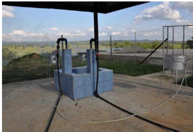
Gambar 7: Tangki digester yang telah siap
