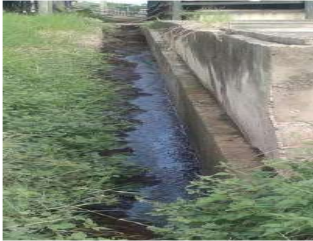
Gambar 14: Gambaran parit yang kubahannya disalurkan terus ke kolam endapan
