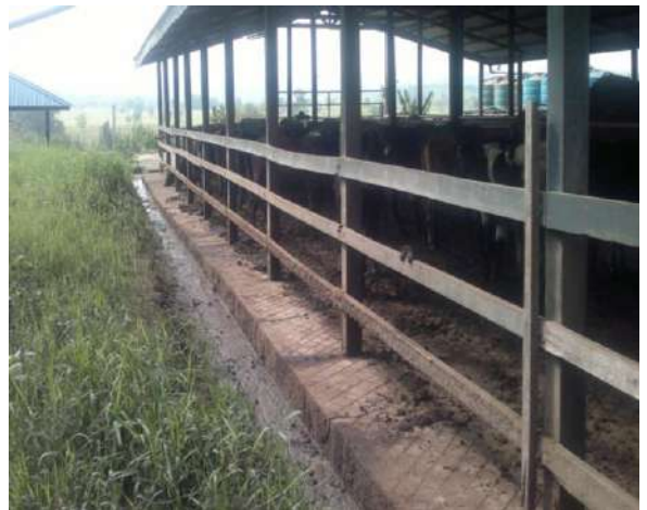
Gambar 15: Gambaran parit yang kubahannya disalurkan ke digester sebelum ke kolam endapan
